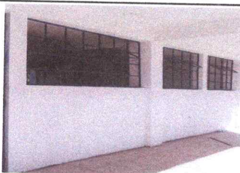
puesta de ventanas faltando los vidrios
