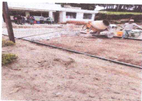
Realización de pavimentación
